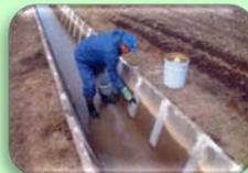
漏水箇所の目地補修等による水路の保安全管理
