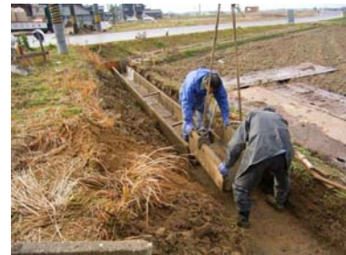
水路の再布設
