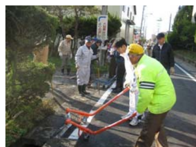
水路蓋の設置 (専用器具使用)
