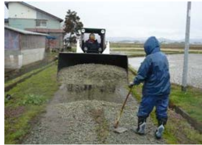
砂利の敷き均し
