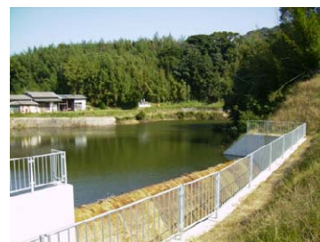
金網フェンスの 設置状況
