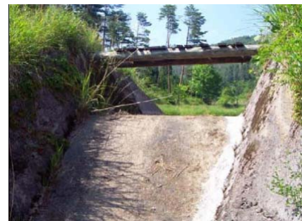
洪水吐の補修
