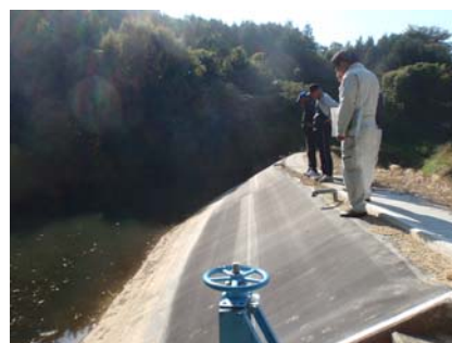
遮水シートの設置
