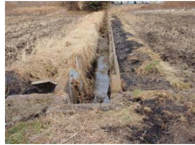
老朽化した水路（全景）
