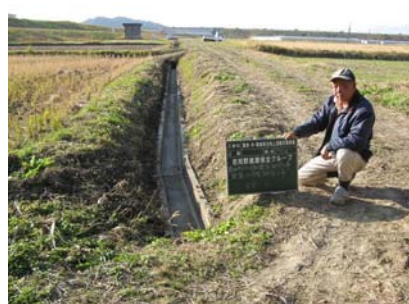
土側溝をコンクリート側溝に更新
