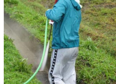
高圧洗浄機による 水路内の清掃
