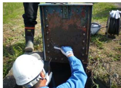
ゲートの補修状況
