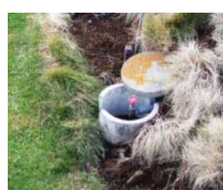
【給水栓の補修・更新】 突発的な破損への対応
