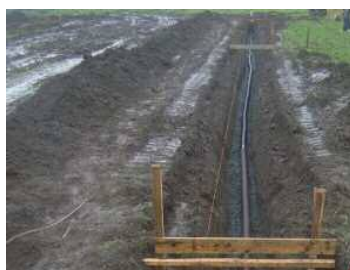
【暗きょ排水の補修設置、客土・心土破碎の施工】 遊休農地発生防止のための取組
