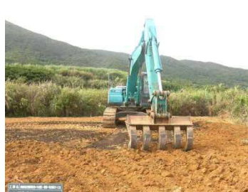
【暗きょ排水の補修設置、客土・心土破碎の施工】 遊休農地発生防止のための取組
