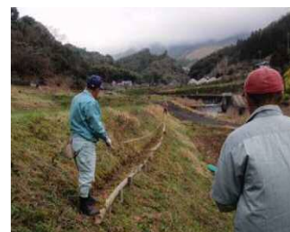
【法面の小段設置】 法面管理のための安全対策
