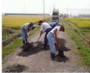
共同作業による砂利の敷き均し
